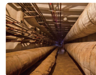
Získavanie informácií z podzemia
