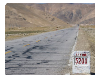
Cestné geodetické práce
