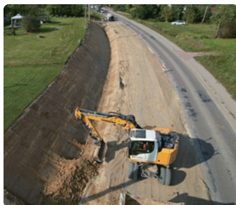
Výstavba ciest a diaľnic
