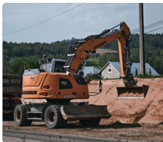
Výstavba svahov a násypov
