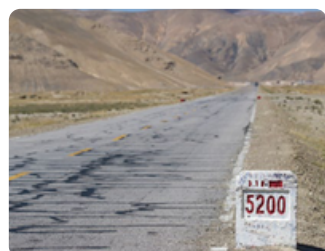
Cestné geodetické práce
